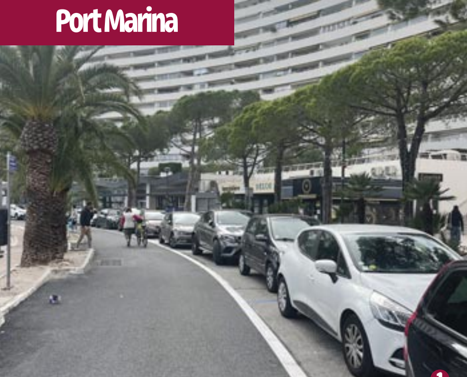
1 Rénovation de la Croisette André Minangoy. Coût : 1.600.000 € (dont 390.000 € reprise des éclairages - installation de bornes festives pour la commune)
