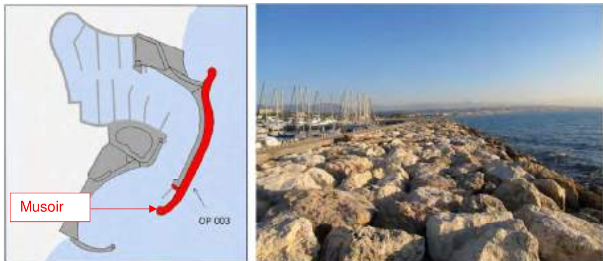
Localisation et photographie de la digue existante
