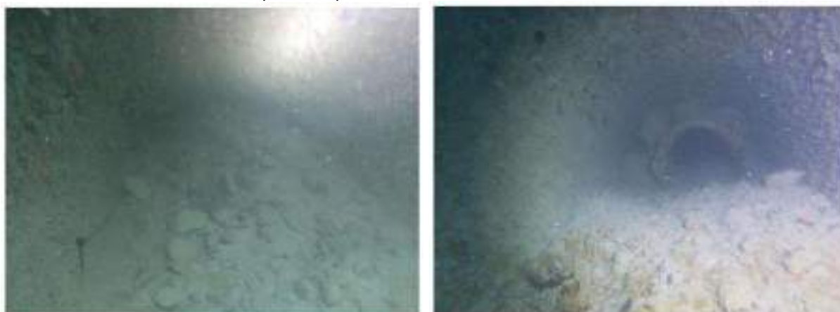
Figure 13 - Illustrations des dépôts au droit des émissaires pluviaux du port
