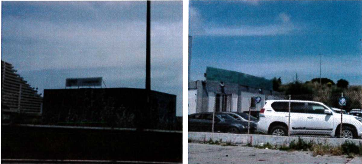
Enseignes sur toiture ou terrasse en tenant lieu réalisées en panneau de fond, Villeneuve-Loubet, Juin 208.
