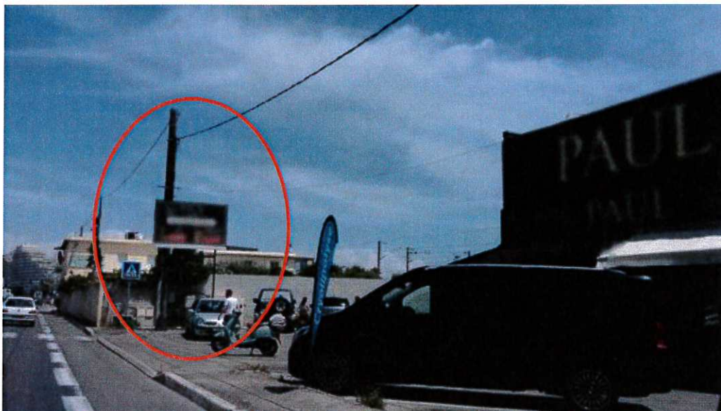
Enseigne scellée au sol ou installée implantée trop proche de la limite séparative du propriété, Villeneuve-Loubet, Juin 2018.
