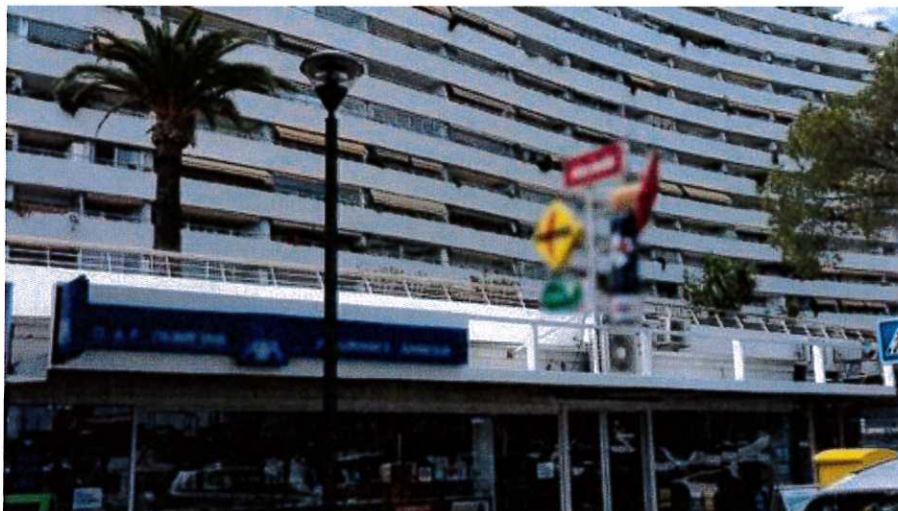
Enseignes perpendiculaires au mur dépassant des limites du toit, Villeneuve-Loubet, Juin 2018
