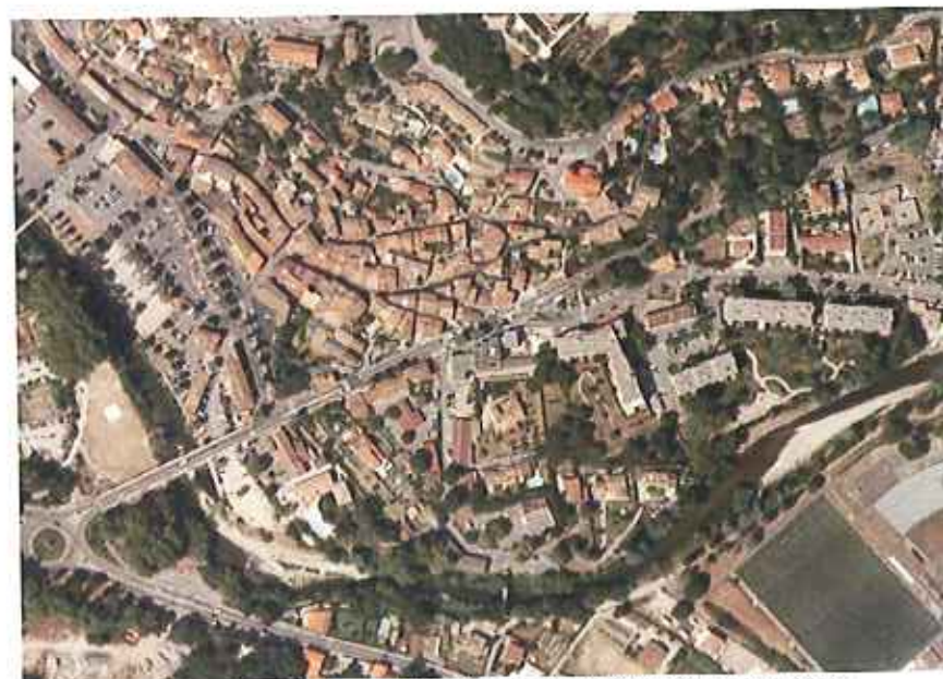
Figure 142 : Photographie aérienne du quartier de Font Bertrane
