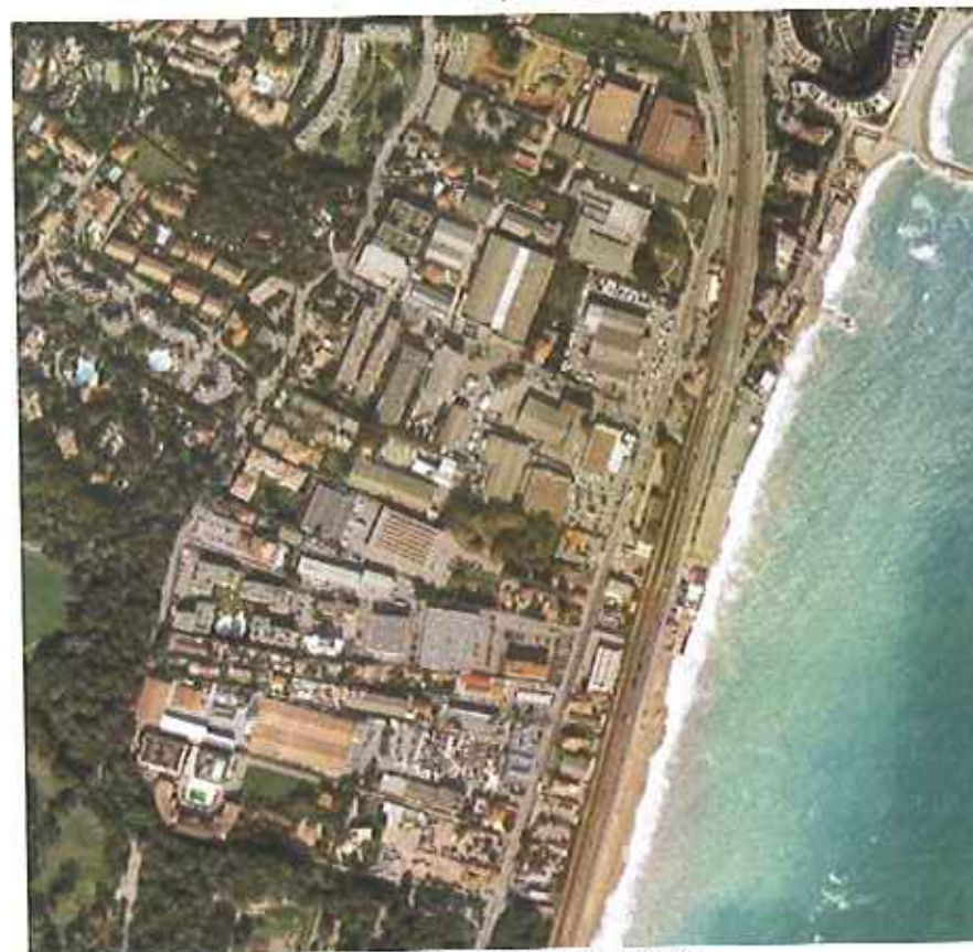
Figure 92 : Photographie aérienne du quartier des Maurettes
