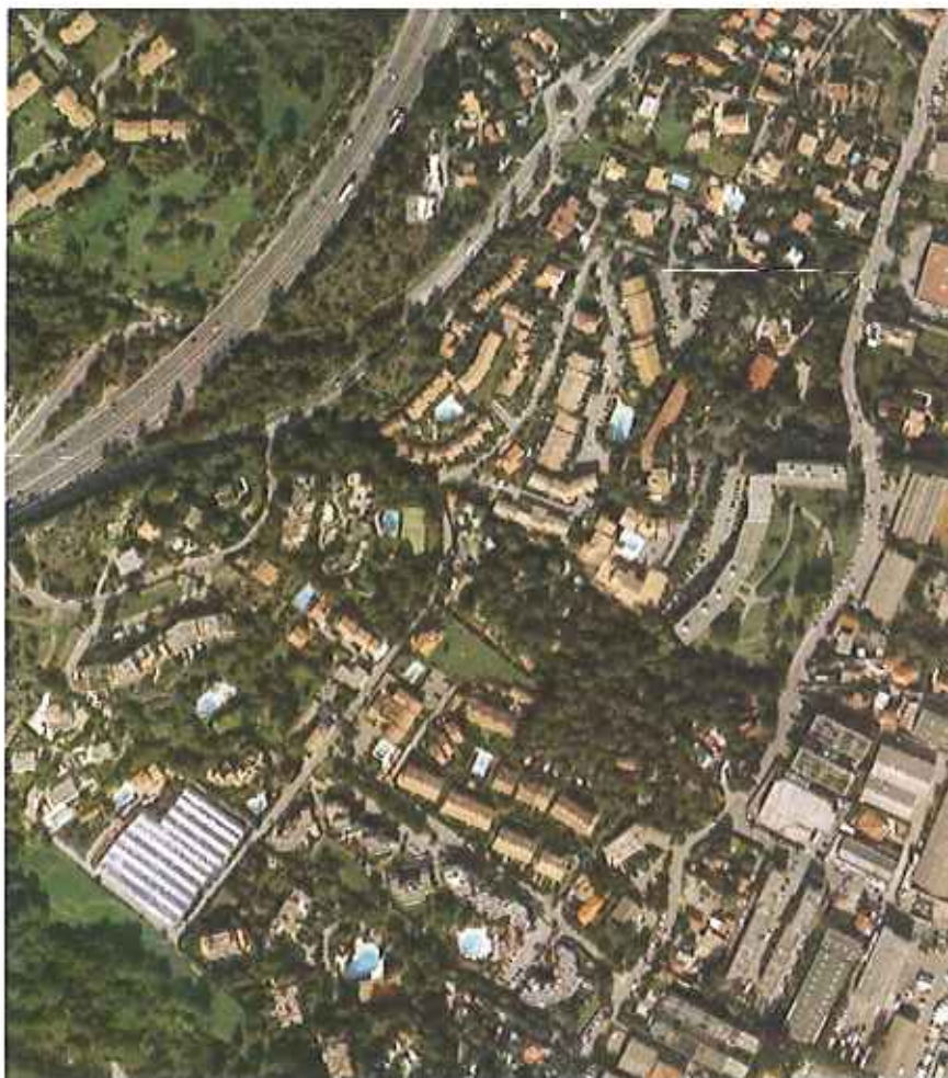
Figure 100 : Photographie aérienne du quartier des Maurettes
