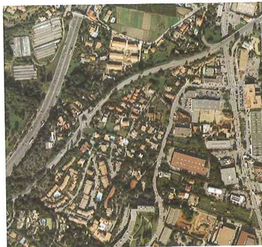
Figure 124 : Photographie aérienne du quartier des Baumettes
