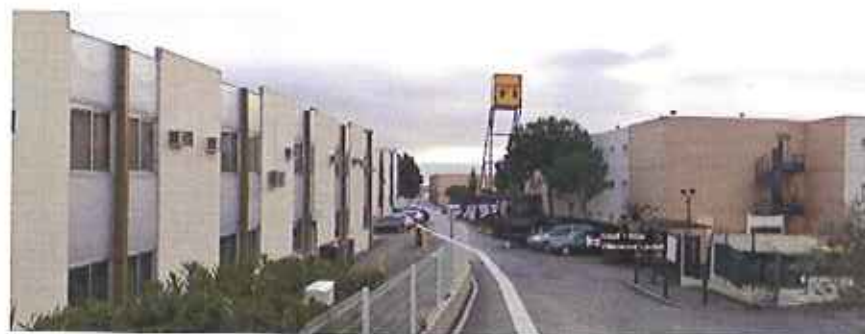
Figure 94 : Route perpendiculaire qui relie l'avenue du Logis de Bonneau à la RD6007 (voirie concernée par l'emplacement réservé V.17)
