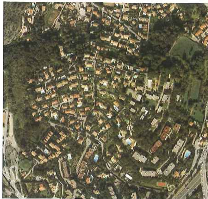
Figure 114 : Photographie aérienne du quartier des Basses Ginestières
