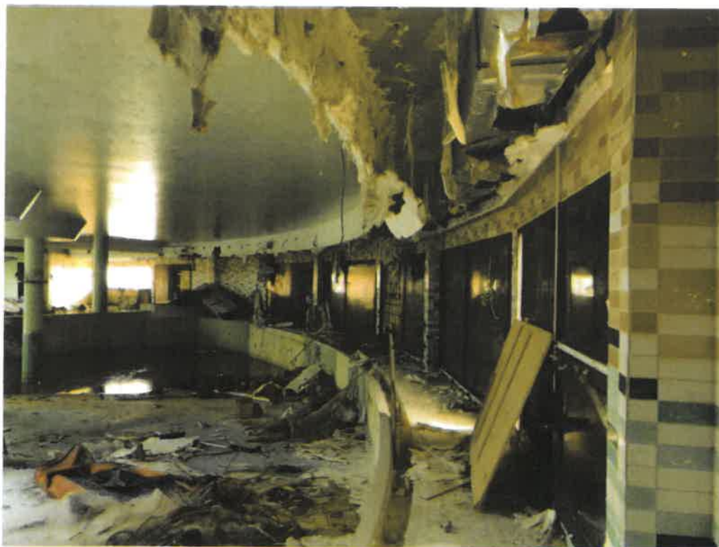
Intérieur du bâtiment existant
