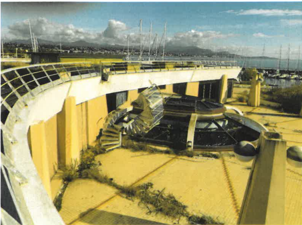
Toiture du bâtiment existant
